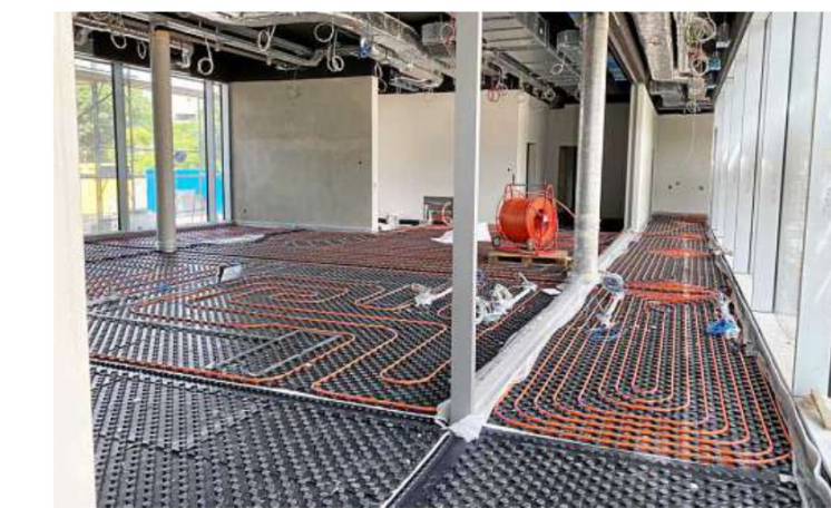
Verlegung der Fußbodenheizung im Aloha. Die Eröffnung verschiebt sich voraussichtlich in den Herbst.
